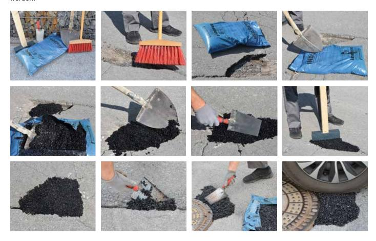
**VERARBEITUNG**: Das Verlegen und Anpressen des Materials erfolgt einfach von Hand mit den üblichen Werkzeugen, Schaufel oder Stampfer, aber Sie können auch Rüttelplatten oder eine schwere Rolle verwenden.
