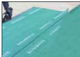
Mechanische Befestigung
